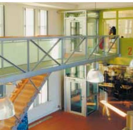
La **plate-forme élévatrice** DomusLift est conforme à la Directive Machines.
